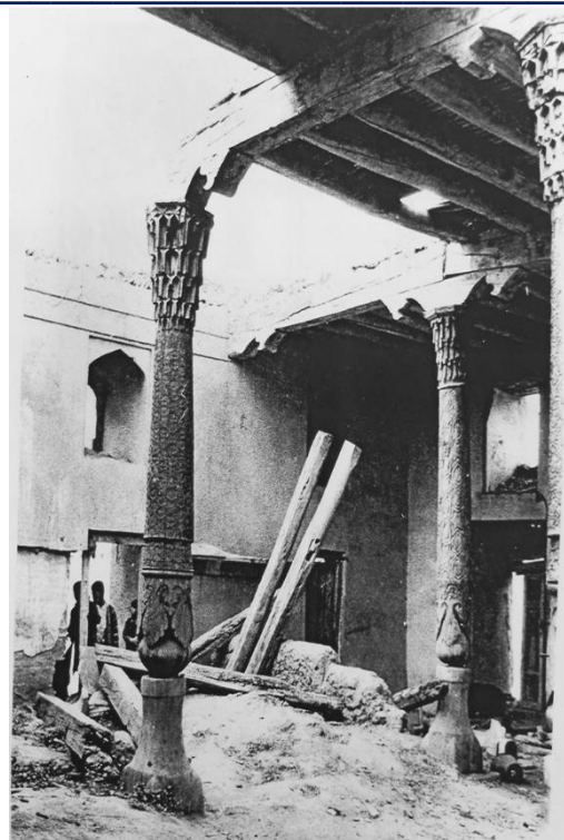
Состояние мечети до реставрации.
