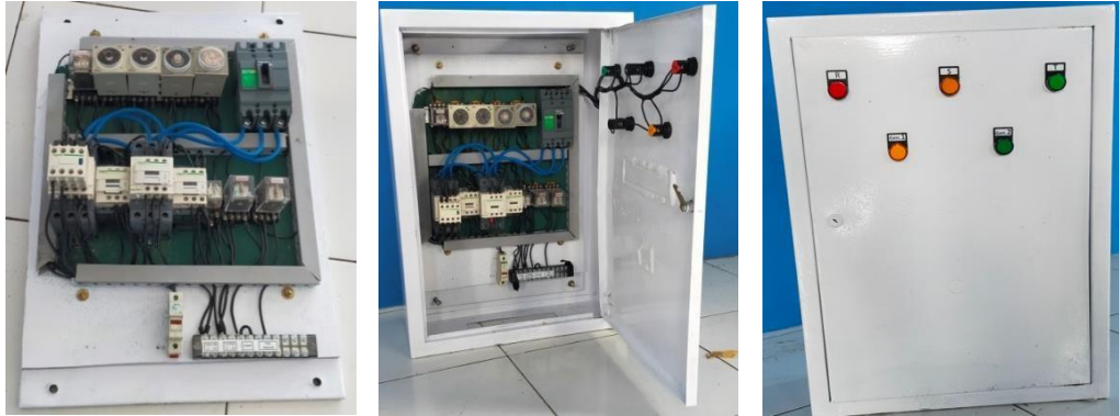
Gambar 23 Bentuk visualiasi perancangan desain alat sistem start genset otomatis ATS-AMF
